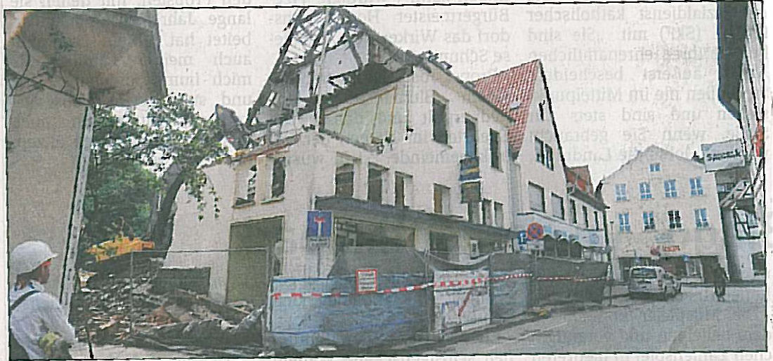
Platz für einen Neubau: Der Abrissbagger schafft Fakten im Grandweg. ■ Foto: Niggemeier
