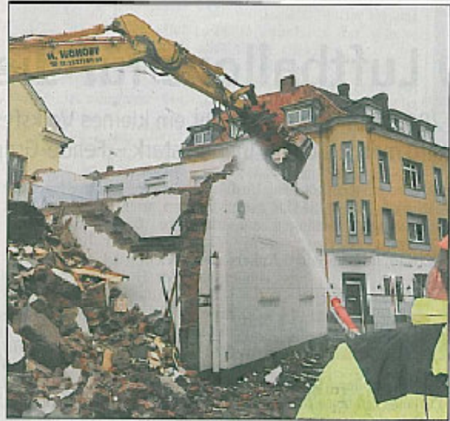
Da blieb kein Stein über dem anderen, als der Abriszbagger in dieser Woche am Grandweg 34 zulangte. • Foto: Dahm
