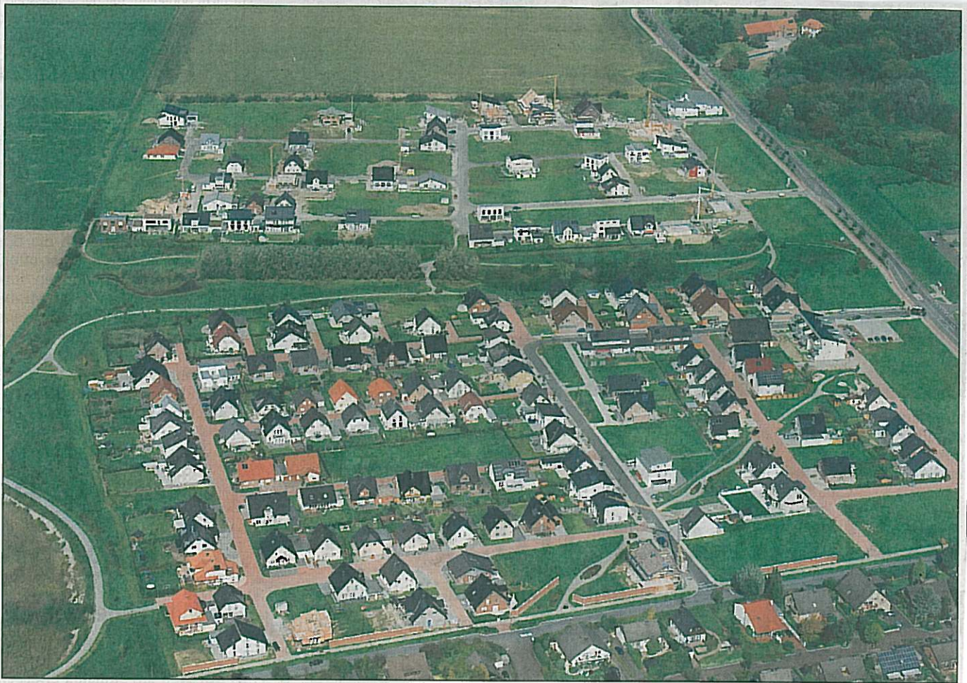
Im Soester Westen am Ardey wird fleißig gebaut. Schon in wenigen Jahren dürfte das größte Siedlungsquartier der Stadt „vollgelaufen“ sein. Höchste Zeit, nach neuen Baugebieten Ausschau zu halten, heißt es in der Pestel-Studie. ■ Foto: Bernhard Fischer
