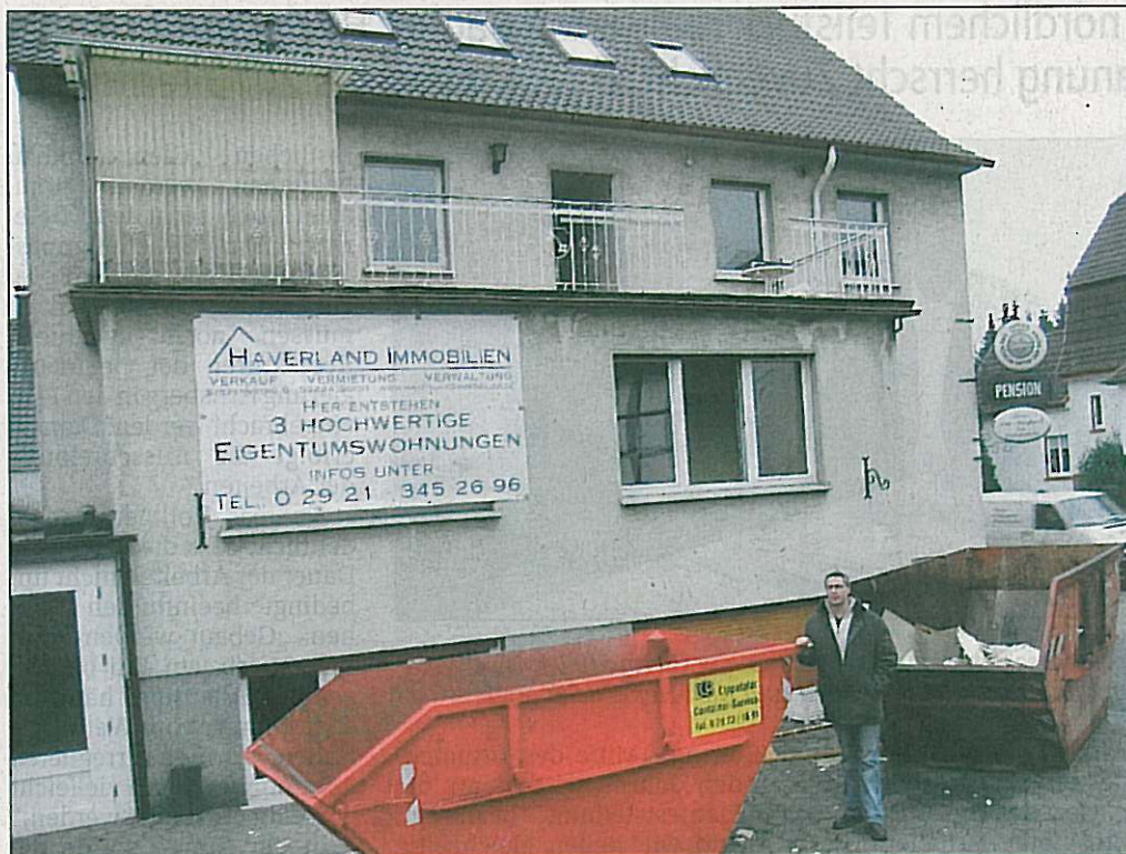
Komplett umgebaut wird durch Bauherr Joachim Jatzkowski das Gebäude der Pension „Haus am Kurpark“ Ecke Wiesenstraße/Salzstraße. Anschließend soll der Komplex als Eigentumswohnungen vermarktet werden. ■ Foto: Tenberge
