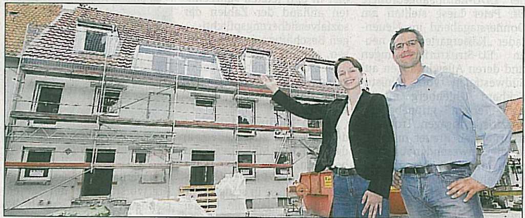
Einst Kräuterschmiede, heute Eigentumswohnungen: Katrin Haverland und Joachim Jatzkowski präsentieren das alte Wippermann-Gebäude nahe des Hohen Wegs. ■ Foto: Dahm
